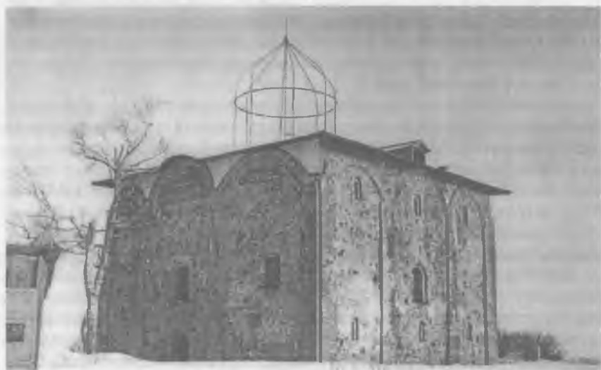
8. Вид с северо-запада после реставрации. Снимок 1976 г.
