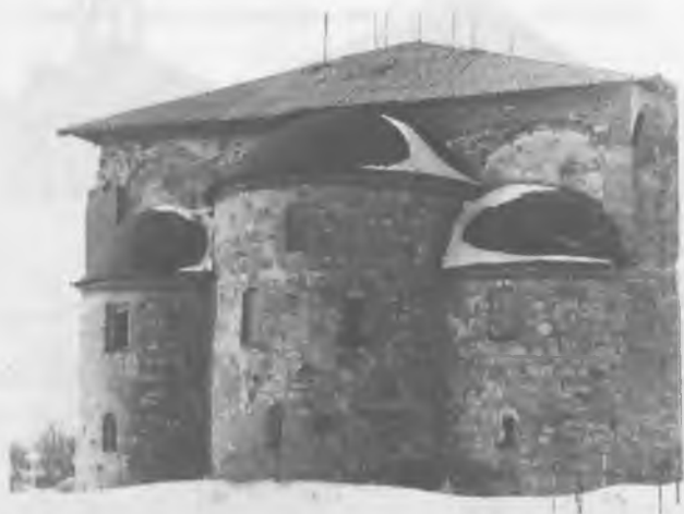
11. Восточный фасад церкви Воскресения после реставрации
