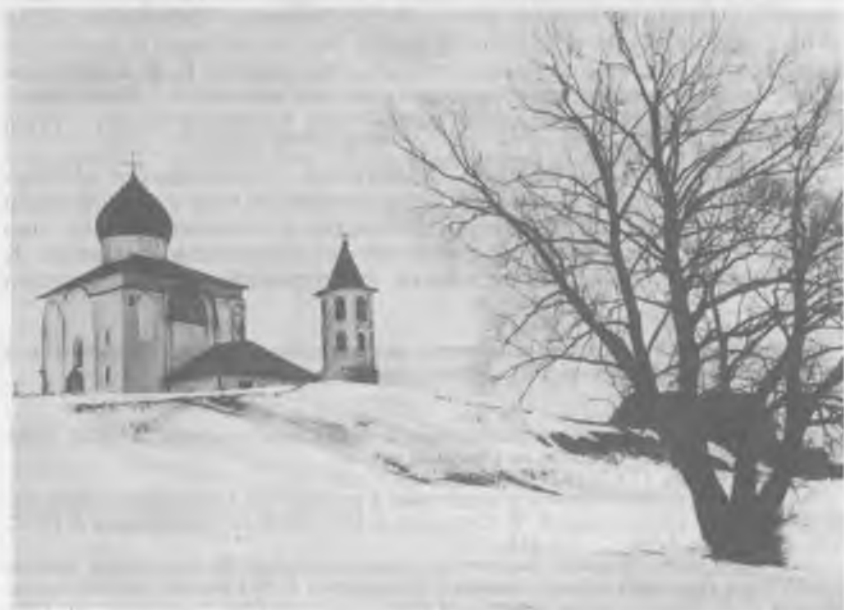
Рис. 2. Церковь Спаса на Нередице. Вид с северо-запада. Конец XIX—начало XX в. (до реставрации 1903—1904 гг.).
