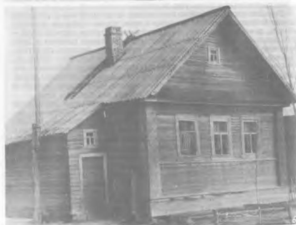
Рис. 4. Способы обшивки домов тесом.
