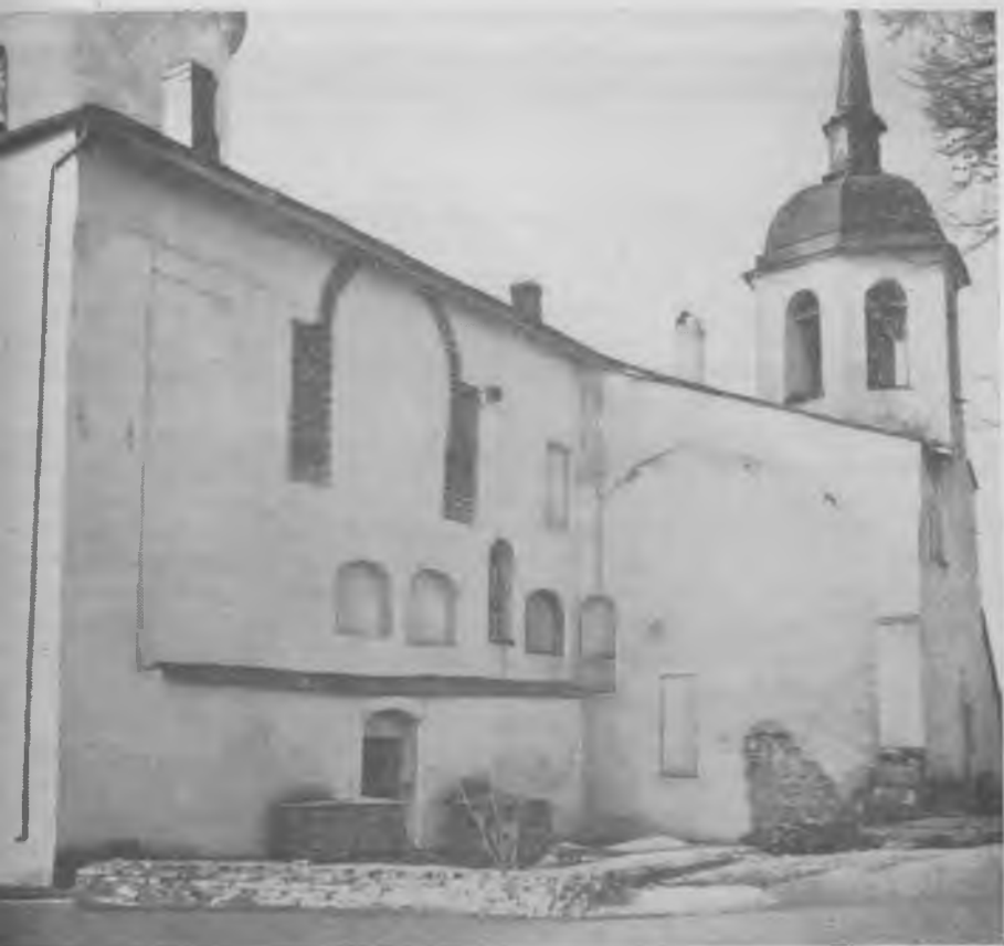
Колокольня (XVIII в.) церкви Филиппа Апостола на Нутной улице (до реставрации).
