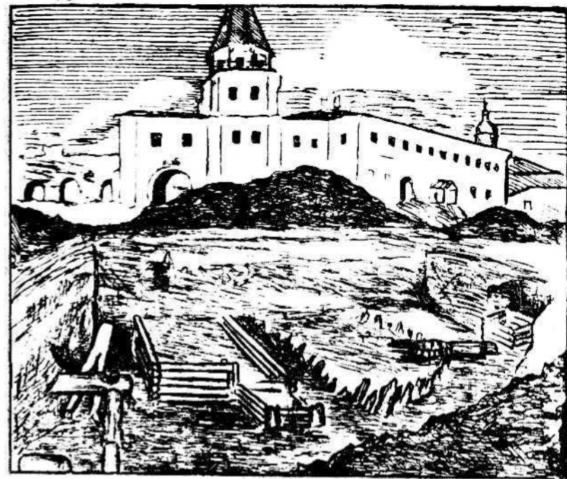
Раскопки на Ярославовом Дверище 1946 г. Остатки деревянных сооружений.
