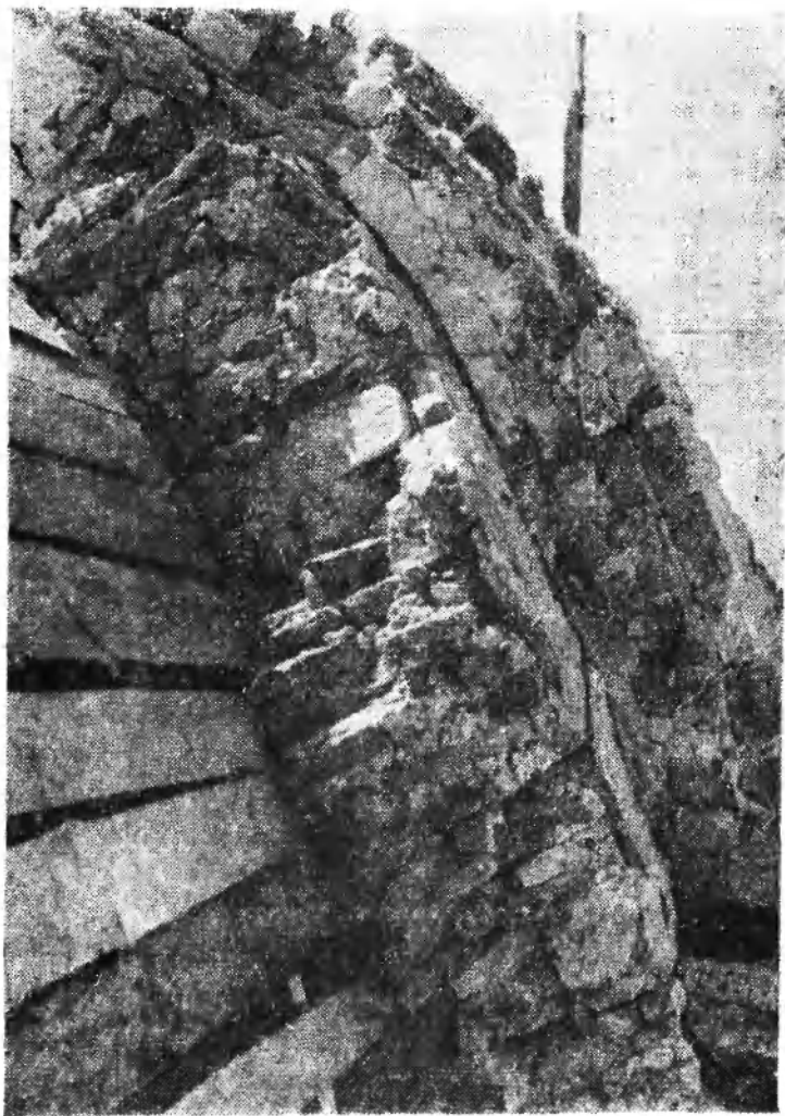
Рис. 10. Фрагмент центрального западного свода Нередицкой церкви (кладка свода в один перекат).
