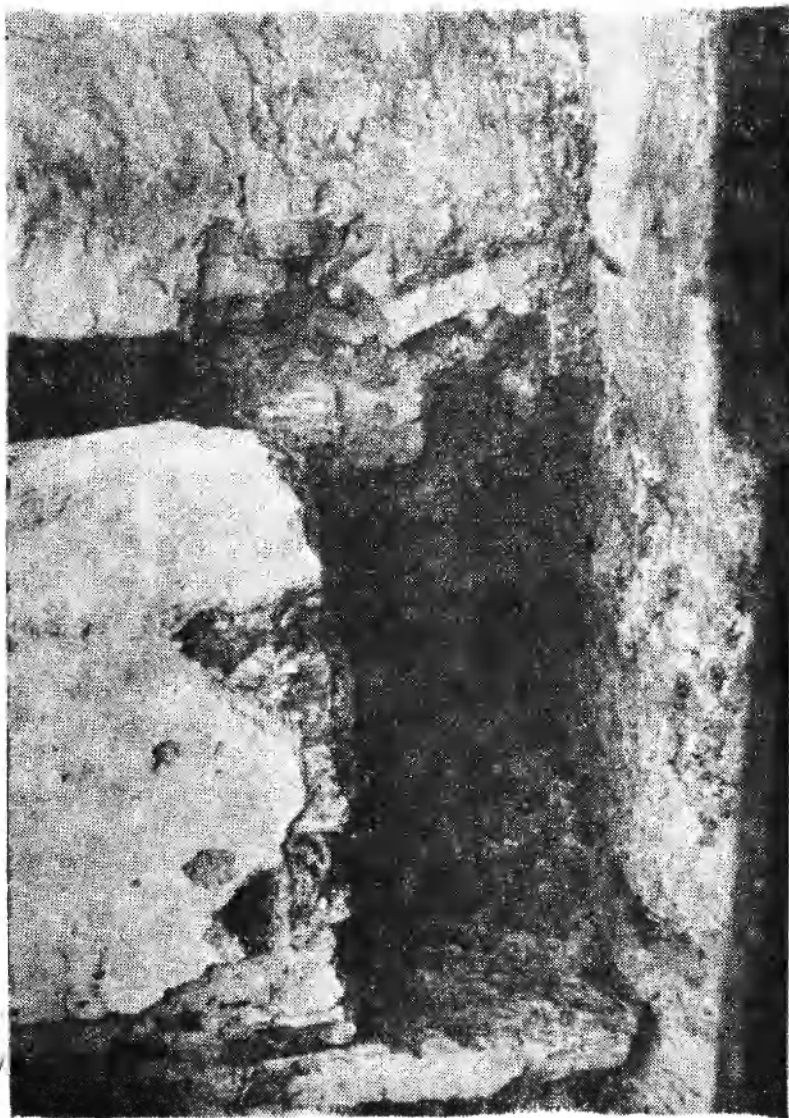
Рис. 5. Зондаж верхней части кладки южной апсиды. Разобрана позднейшая накладка в месте примыкания к центральной апсиде.
