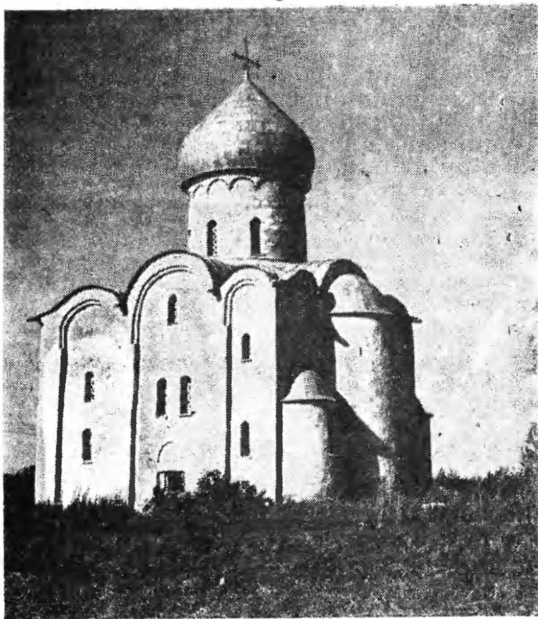
Рис. 3. Нередицкая церковь после восстановительно-реставрационных работ.
